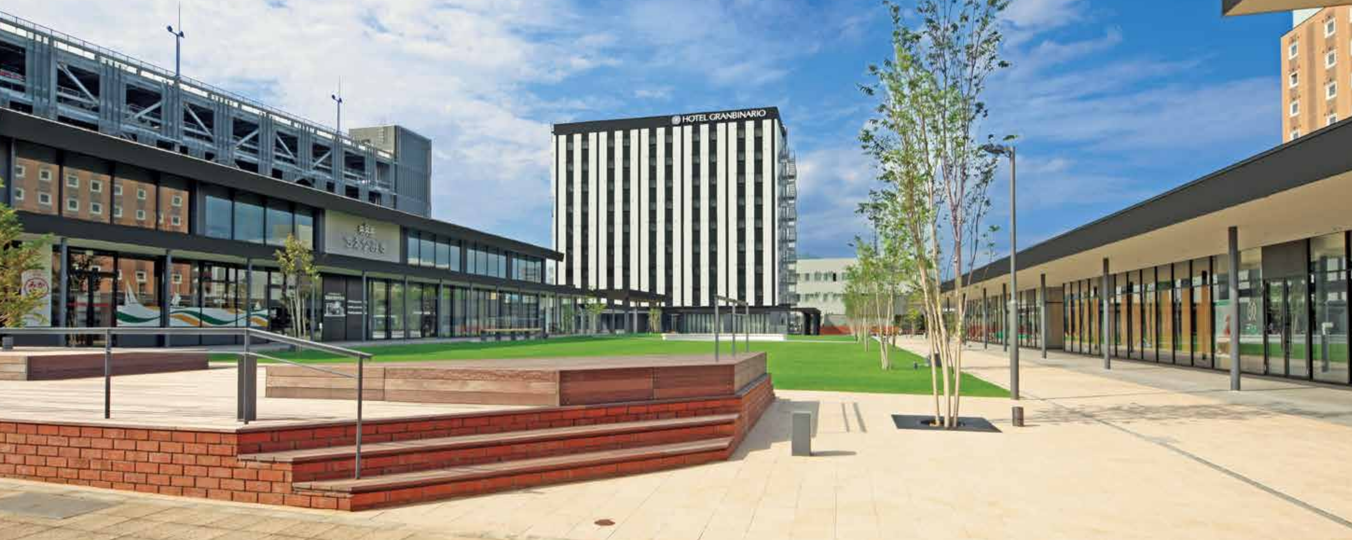
広場越しに見る。左が複合棟、中央がホテル棟（ホテルグランビナリオTSURUGA）、右が低層棟
