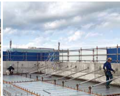
パラペットPC設置状況
