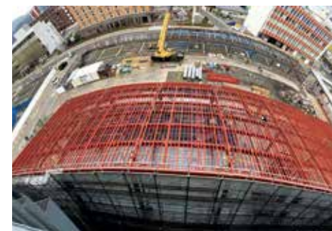
複合棟鉄骨建方状況
