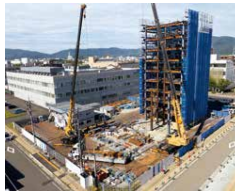
鉄骨建方状況
